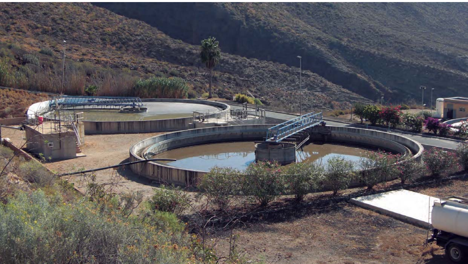
Foto 8.2. EDAR visitada en el proyecto
