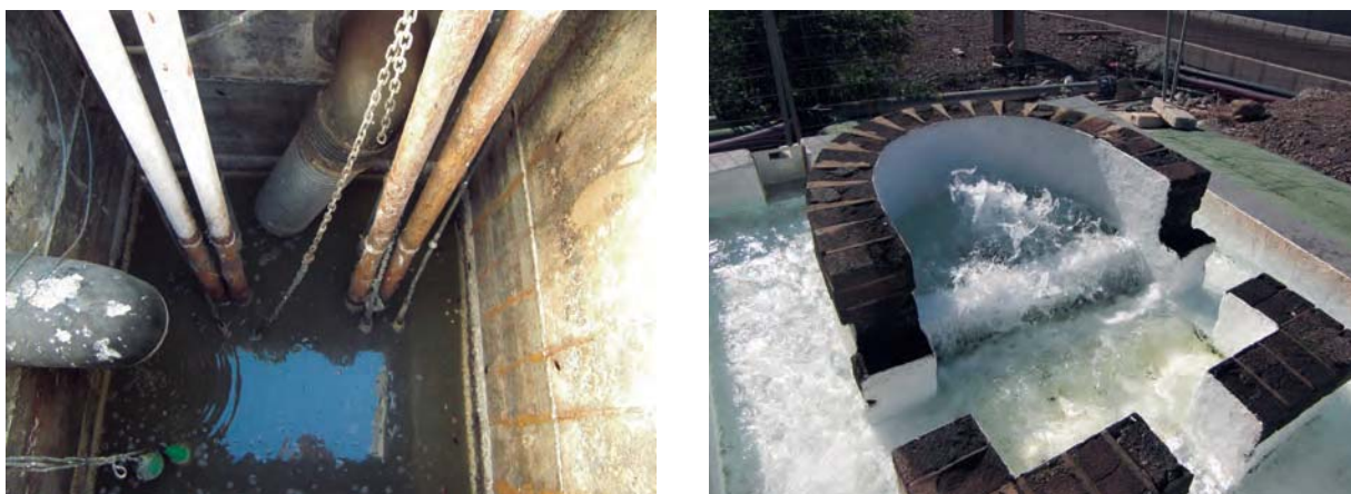
Foto 8.3. Detalles de canalizaciones y obras hidráulicas en EDARs visitadas
