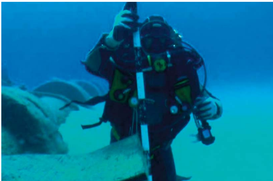
Foto 6.1. Campaña de inspección del tramo difusor del emisario
